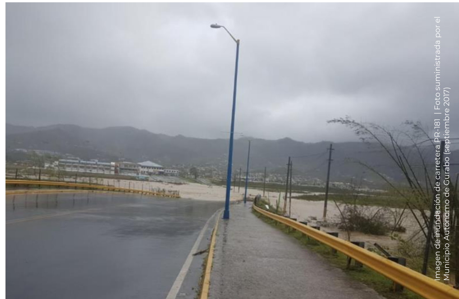
Imagen de daños al Complejo Deportivo en Jaguas | Foto suministrada por el Municipio Autónomo de Gurabo (septiembre 2017)
