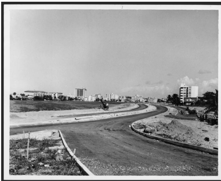
Relleno del litoral sur de la Laguna del Condado como parte de la construcción de la Ave. Román Baldorioty de Castro. Foto de Roberto Mora publicada en el periódico El Mundo el 30 de marzo de 1960. Colección de fotos del periódico El Mundo. Universidad de Puerto Rico, Recinto de Río Piedras.
